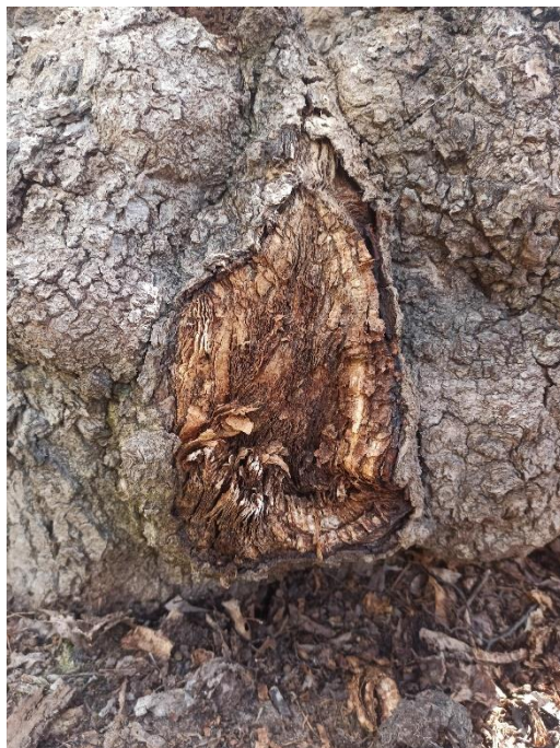
fot. 1.4.3.4 Uszkodzenie mechaniczne narośli
