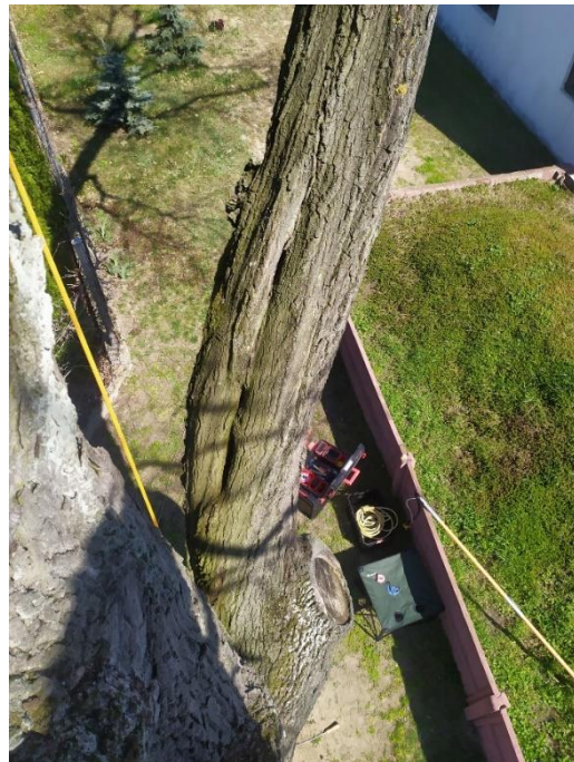
fot. 3.4.4.4 Ubytki otwarte (NE)
