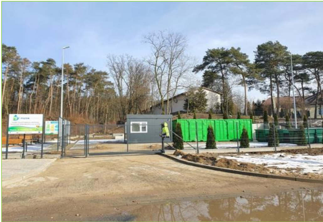
Zdjęcie 12. Realizacja inwestycji Punkt Selektywnej Zbiórki Odpadów Komunalnych w Słupnie
