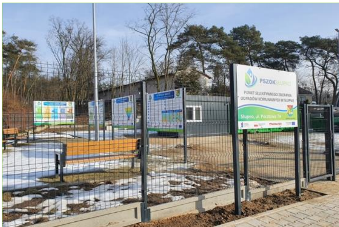
Zdjęcie 11. Realizacja inwestycji Punkt Selektywnej Zbiórki Odpadów Komunalnych w Słupnie
