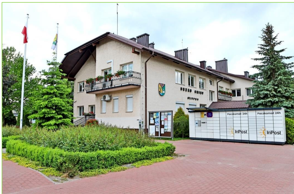
Zdjęcie 1. Budynek Urzędu Gminy w Słupnie
