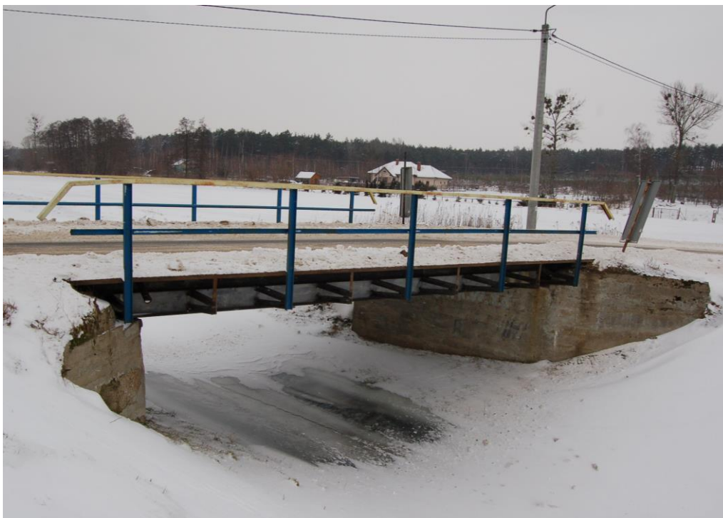
Fot.2 Widok ogólny obiektu od strony górnej wody
