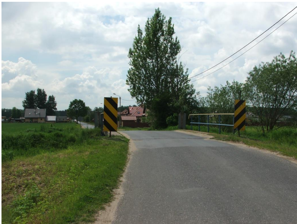
Fot.1 Widok z poziomu nawierzchni na obiekcie
