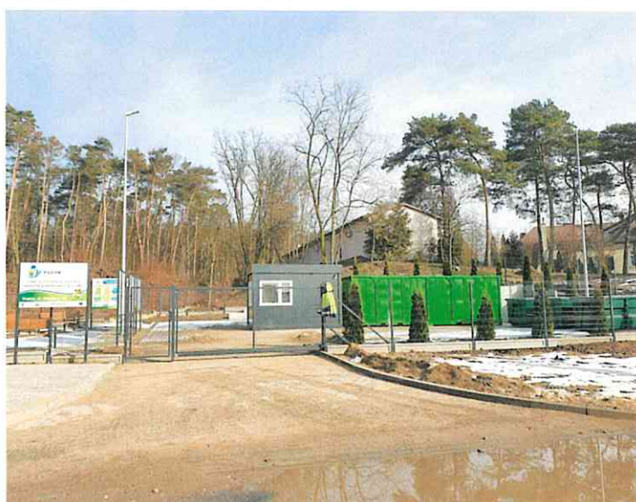
Fot. 2 Realizacja inwestycji Punkt Selektywnej Zbiórki Odpadów Komunalnych w Słupnie
