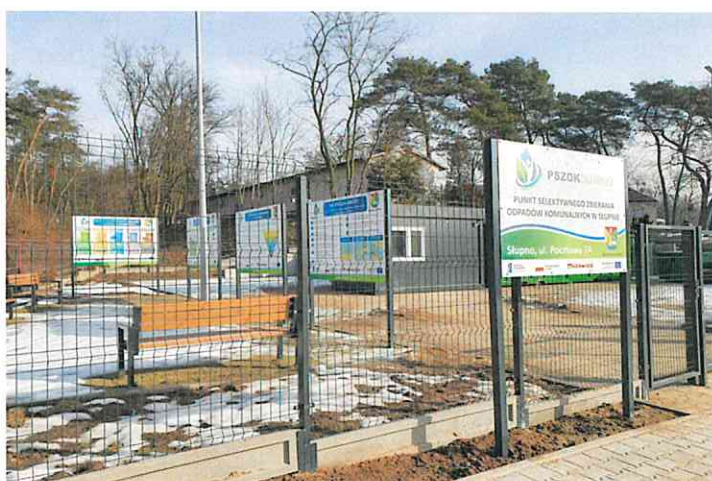
Fot.1 Realizacja inwestycji Punkt Selektywnej Zbiórki Odpadów Komunalnych w Słupnie
