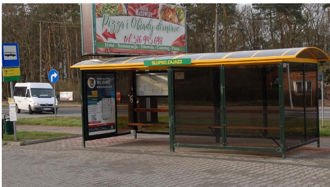
Zdjęcie 7. Wiata przystankowa przy Miszewskiej w Słupnie
